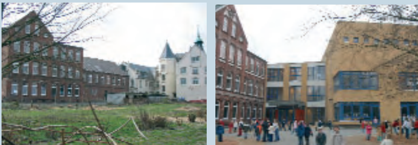
Abb. 5.21/5.22: Zwingli-Schule vor und nach dem Umbau
