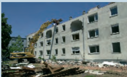
Abb. 5.12: Abbruch eines Wohngebäudes im Winzler-Viertel
