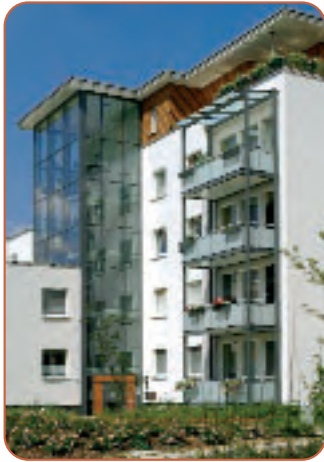
Abb. 11.6: Umgebautes Wohnhaus in Oer-Erkenschwick
