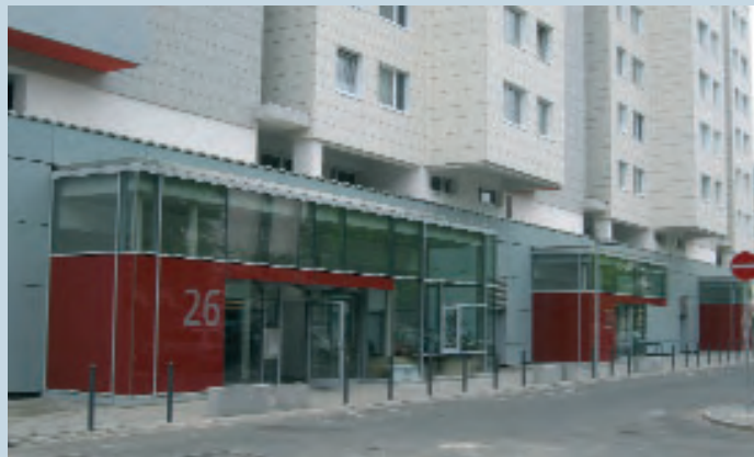
Abb. 4.11: Wohngebäudeteil nach der Modernisierung
