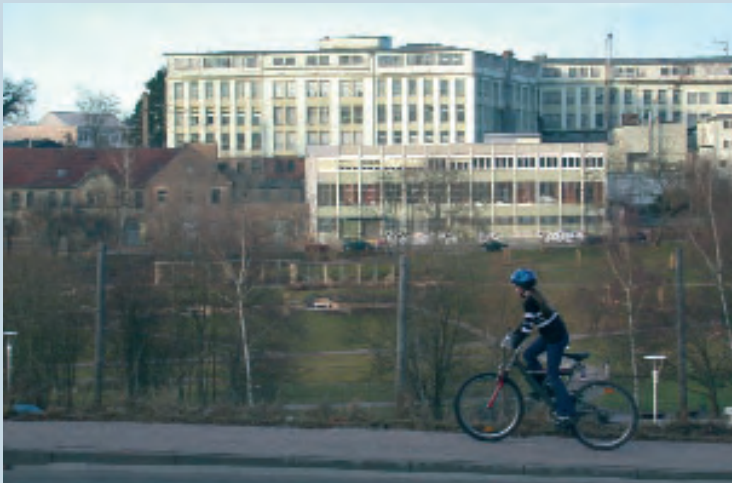
Abb. 4.12: Rheinberger vor dem Umbau
