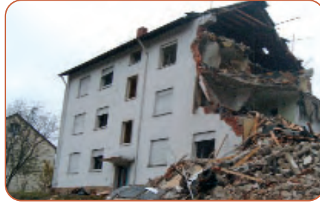
Abb. 5.8: Rückbau-Vorhaben in Wildflecken
