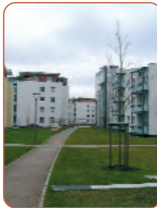
Abb. 4.15: Wohnanlage Schillerpark in Oer-Erkenschwick nach dem Umbau
