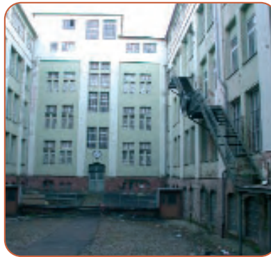
Abb. 5.5: Atrium des Rheinbergers in Pirmasens vor dem Umbau
