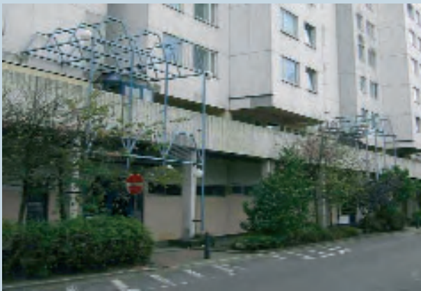
Abb. 4.10: Wohngebäudeteil vor der Modernisierung
