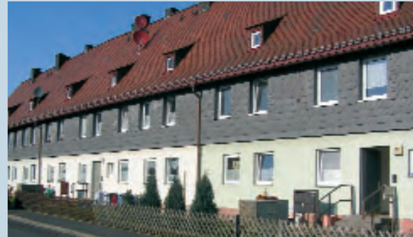
Abb. 8.6: Gebäudebestände an der Fleischhauer Straße
