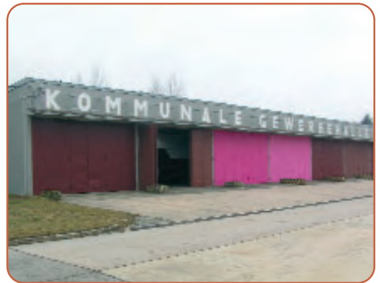
Abb. 4.16: Kommunale Gewerbehalle auf dem Gelände der ehemaligen Rhönkaserne in Wildflecken
