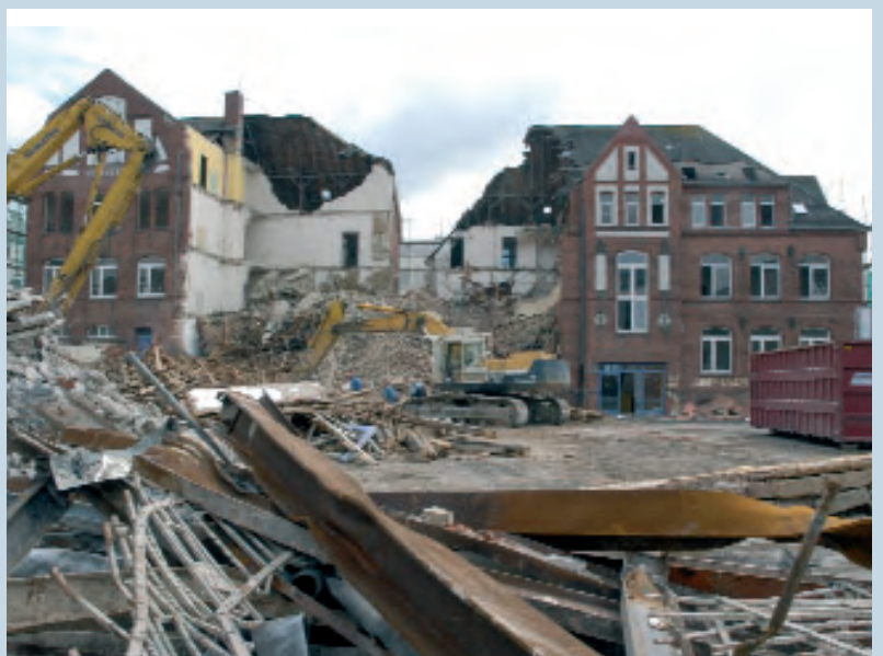
Abb. 4.3: Abbruch der Deichschule
