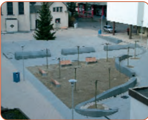
Abb. 4.14: Neu gestalteter Adolph-Kolping-Platz im Ortskern von Völklingen
