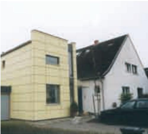
Durch den damit gleichzeitig verbundenen Schutz der Bausubstanz, vermindert eine nachträgliche Außenwanddämmung vorhandene Wärmebrücken, verhindert auf diese Weise zukünftige Bauschäden, verlängert die Lebensdauer des Gebäudes und erhöht seinen Wert. In der Außenwand verlegte Rohrleitungen werden zudem gegen Frosteinwirkungen geschützt.
