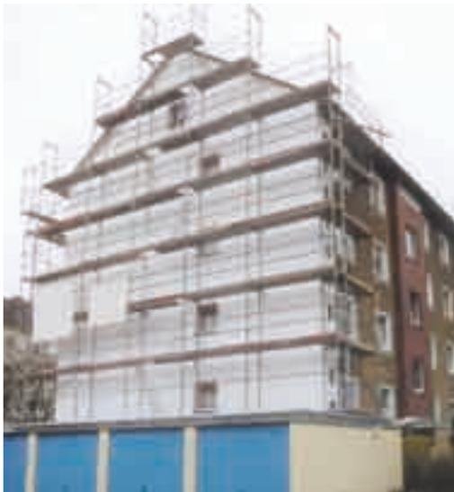
**Abb. 19: Energetische Modernisierung eines Mehrfamilienhauses mit Wärmedämmverbundsystem**
