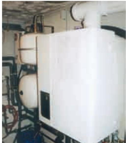
**Abb. 28:** Moderne Brennwertkesselanlage mit solarer Unterstützung der Warmwasserbereitung
