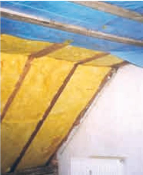
Abb. 23: Nachträgliche Dachdämmung bei einem Einfamilienhaus
