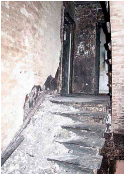
Wohnungstür nach einem Treppenhausbrand von außen... Ana giriş kapısı bir merdiven boşluğu yangınından sonra dışarıdan... Drzwi mieszkania z zewnątrz po pożarze na klatce schodowej... Входная дверь с внешней стороны после пожара ....
