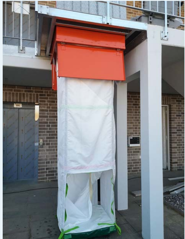
Anlage, mit der sich beeinträchtigte Menschen bei Gefahr (z.B. Feuer) schnell selbstständig retten können.
